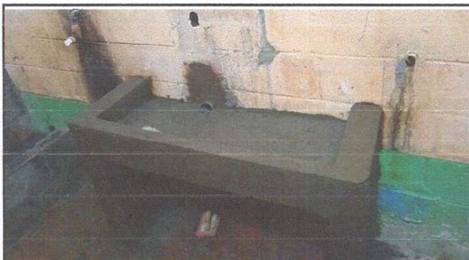
Foto 3: SUSUTITUCIÓN DE LAVAMANOS
