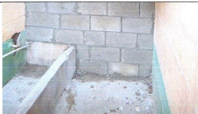
Foto 4: SUSTITUCIÓN DE BAÑOS Y SUS ACCESORIOS. (MINGITORIOS)
