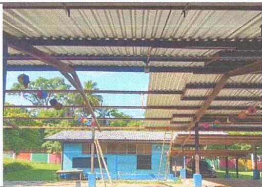
Foto 5: SUSTITUCIÓN DE CUBIERTA DE LAMINA DE SALON
