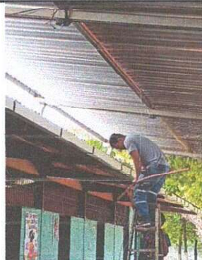
Foto 2: PRIMER MÓDULO DEL ESTABLECIMIENTO Y ÁREA VERDE, REPARACIÓN DE SISTEMA ELECTRICO
